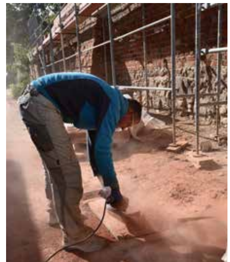
Maßarbeit: Jeder Stein wird passend für die Lücke in der Mauer zurecht gesägt.
